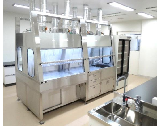
図 1-21 FFU 搭載型 局所排気ユニット
