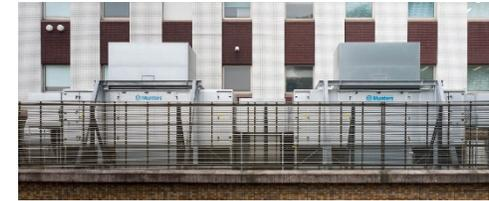
Oasisは、スパコンの熱は、空気のまま屋外に運び、熱交換器を介して外気に捨てます。この時、熱交換器の外側に水をかけることで熱を吸収(水の比熱: 4.2 J/g・K程)、さらに、そこに外気の風を送り水の蒸発を促し(水の汽化熱: 2.2 kJ/g程)、交換機内側の空気を冷やします。冷えた空気が再び室内に戻ります。
