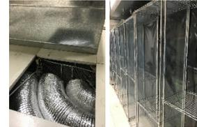
冷気をダクトやプラダンによって冷えてほしい場所に導きます。また、ビニール張りの棚を並べ、都合のよい壁を作り出します。
