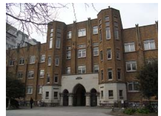
図2. 建物A外観写真
